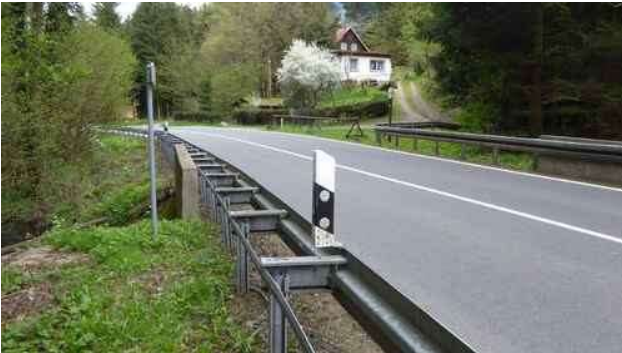
Figure 41. Brücke Steinbach Ri. Friedrichsbrunn.jpg
